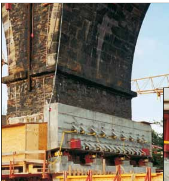
▼ Ein Synchronhubsystem im Einsatz beim Anheben und Überwachen der Brückenlast. Es fand eine Pfeilerkopfanpassung statt, um breitere Fahrbahnen realisieren zu können. Gleichzeitig blieb die Autobahn unter der Brücke und die Schienenverbindung auf der Brücke nutzbar.
