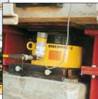
▼ Ein Synchronhubsystem im Einsatz beim Anheben und Überwachen der Brückenlast. Es fand eine Pfeilerkopfanpassung statt, um breitere Fahrbahnen realisieren zu können. Gleichzeitig blieb die Autobahn unter der Brücke und die Schienenverbindung auf der Brücke nutzbar.
