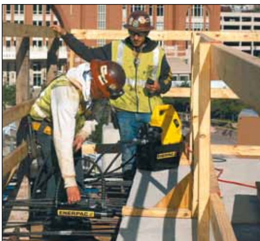
◀ Die ZU4-Serie ist für den harten Baustelleneinsatz mit einem Stahltank ausgerüstet. Die Abbildung zeigt eine ZU4908JE bei einer Vorspannanwendung. Vorspannwerkzeuge, siehe Seite 186.
